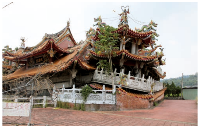
被災した状態で保存されている武昌宮（西谷大撮影、2016年）
